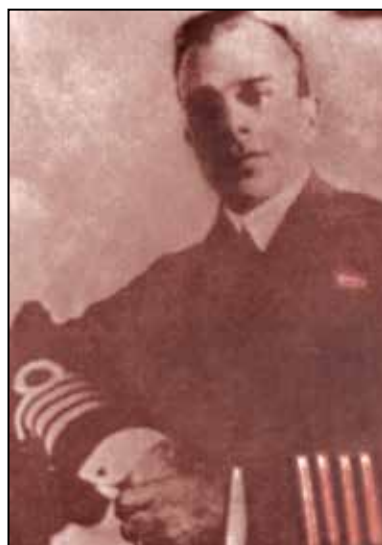
Domingos Marques de Azevedo, primeiro presidente do Flamengo
